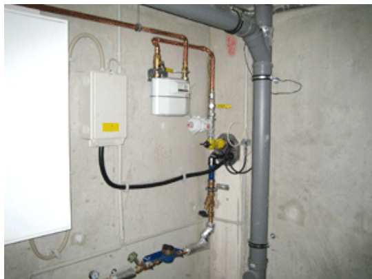
Hauseinführung durch die Kellerwand
