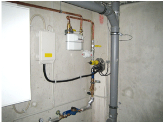
Hauseinführung durch die Kellerwand
